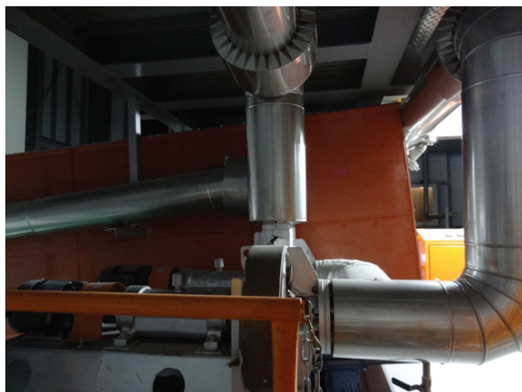
圖：高溫風車煙管與氧氣注入口圖
